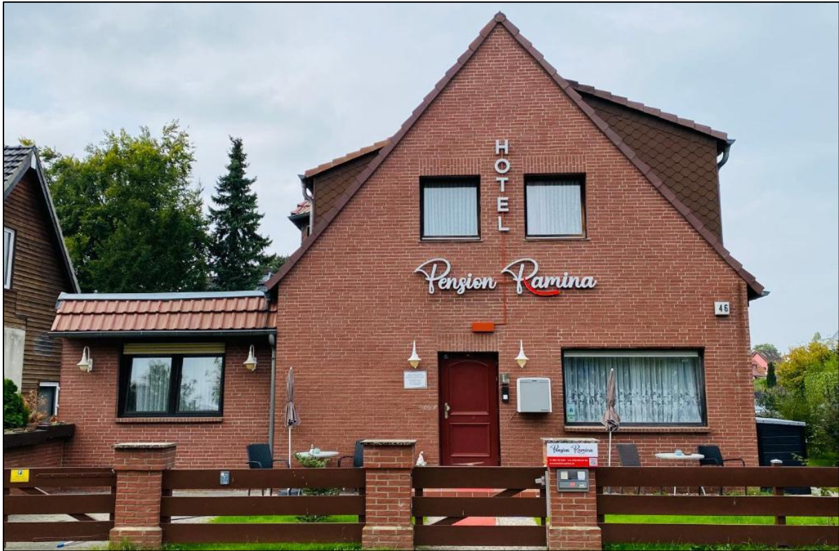
Abbildung 10: Außenansicht Pension Pamina 235
